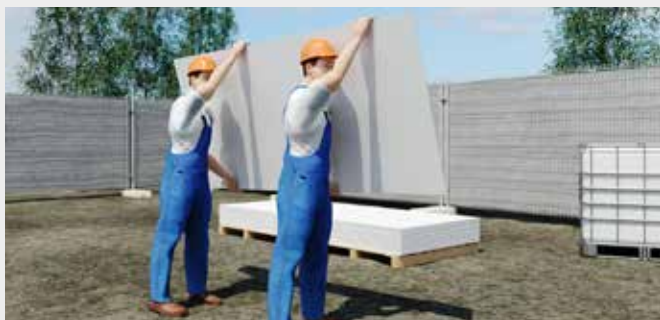
I rivestimenti per facciate HardiePanel® devono essere sempre trasportati in posizione di taglio
