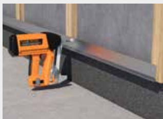
Fissaggio del profilo di ventilazione inferiore speciale per HardiePlank™.
