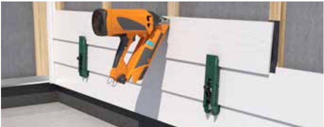
4. Fissare tramite chiodi o viti (senza preforare)
