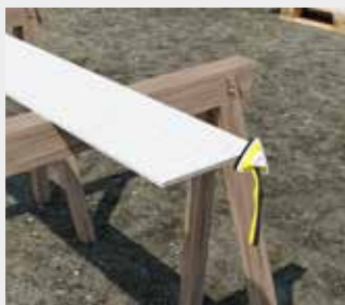
Applicazione della vernice sigillante per bordi ColourPlus™ prima del montaggio.
