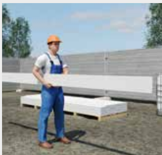
Durante il montaggio, trasportare le doghe HardiePlank® sempre in posizione di taglio.
