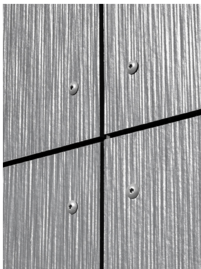
Hardie® Panel Fissaggio con viti
